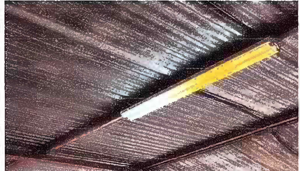
Foto 2: MODULO 1: SUSTICIÓN DE LAMPARAS
