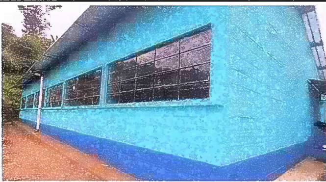
Foto 3: MODULO 1 : PINTURA EN MUROS EXTERIORES E INTERIORES
