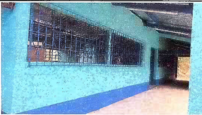
Foto 4: MODULO 1: SUSTITUCIÓN DE BALCONES
