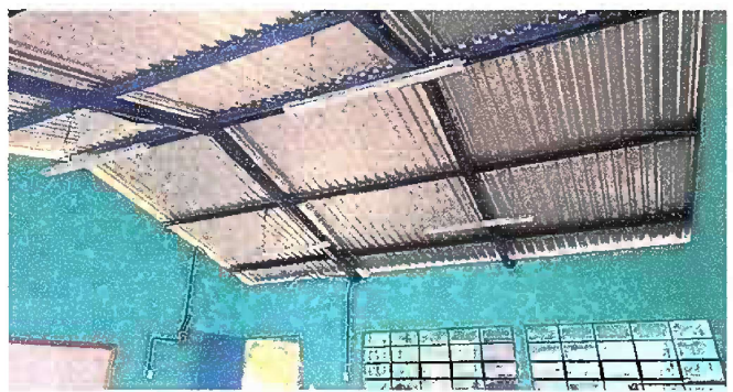
Foto5: MODULO 1: SUSTITUCIÓN DE LÁMPARAS
