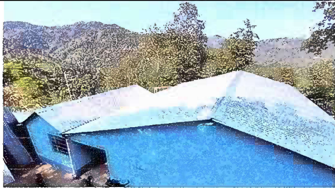
Foto1: MODULO 1: SUSTITUCIÓN DE LÁMINA
