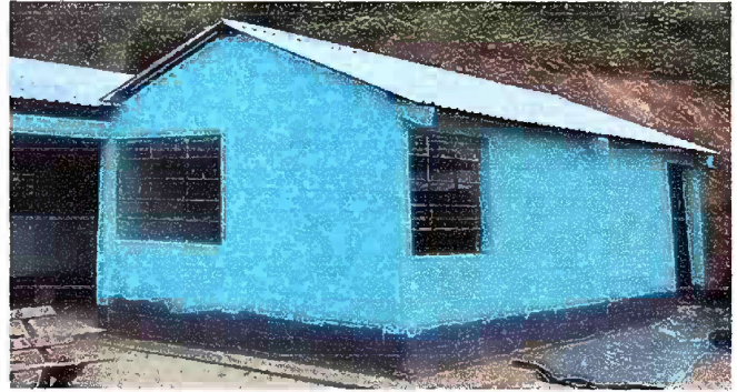
Foto 8: MODULO 2: PINTURA EN MUROS EXTERIORES E INTERIORES
