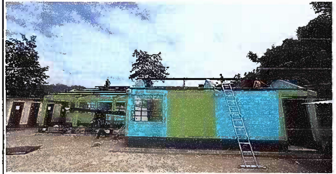
Foto 2: MODULO 1: SUSTITUCIÓN DE CANAL
