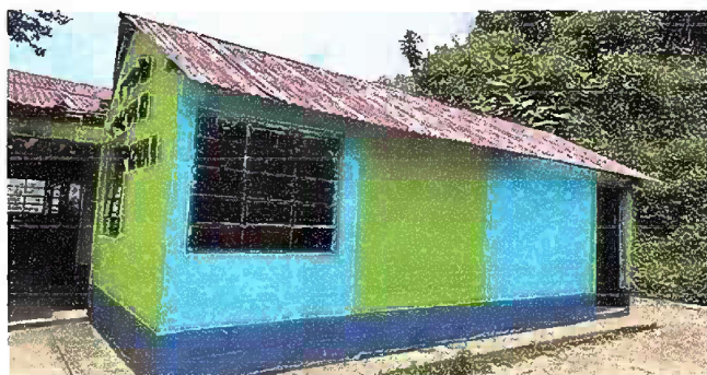
Foto 8: MODULO 2: PINTURA EN MUROS EXTERIORES E INTERIORES
