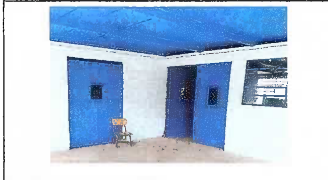
FOTO 2: SUSTITUCION DE PUERTA
