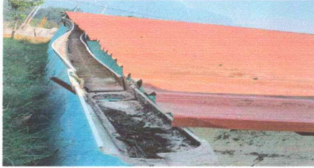
Modulo 1. Mantenimiento de Lamina troquelada.
