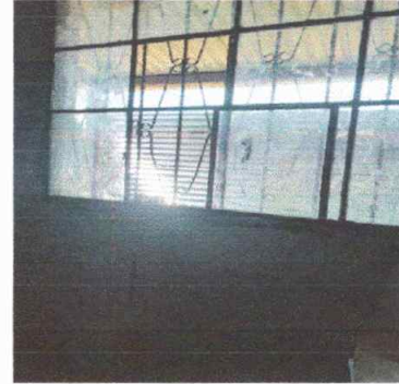
Modulo 1. Mantenimiento de ventanas.
