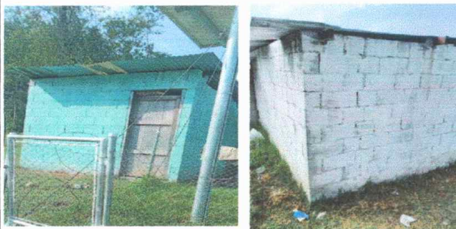
Modulo 2. Sustitución de muro de block, techo y puerta.
