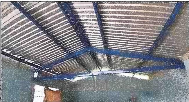
Foto 3: MODULO 2 Sustitucion de estructura de soporte de metal, por metal
