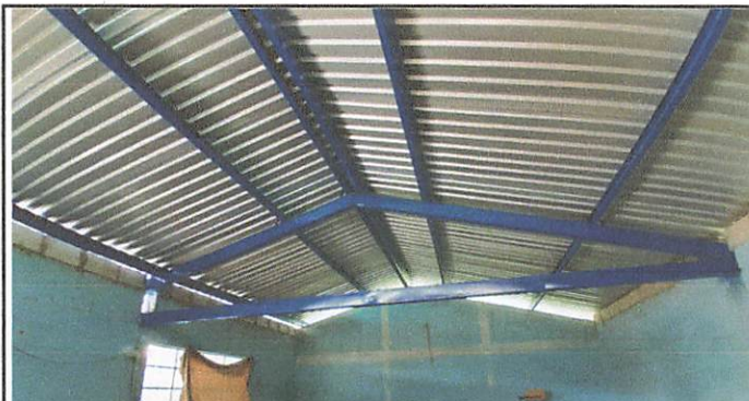
Foto 4: MODULO 2 Sustitución de estructura
