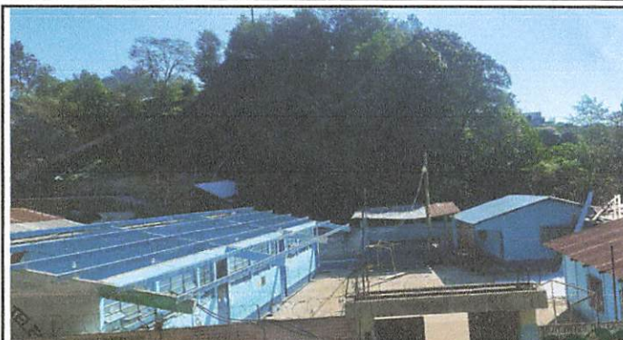
Foto 2: MODULO 1 Mantenimiento a estructura de soporte de metal
