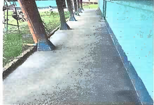
Módulo 1: Sustitución de piso de ladrillo a piso de concreto
