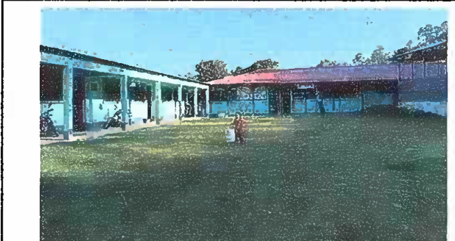
Módulos 1 y 3: Colocación de canales y bajada de agua pluvial
