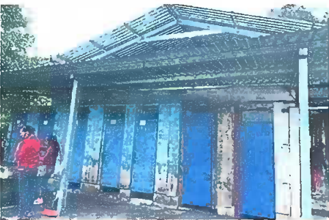
Módulo 2: Sustitución de puertas de madera a metal, lámina a lámina troquelada y sustitución de estructura de madera a metal.
