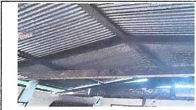
Módulo 4: Sustitución de Lámina a lamina troquelada y sustitución de estructura portante de madera a metal.
