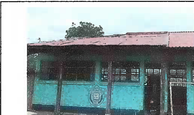
Módulo 1: Sustitución de lámina por lámina troquelada y sustitución de estructura portante de madera por metal.
