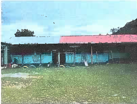
Módulo 1: Sustitución de lámina por lámina troquelada y sustitución de estructura portante de madera por metal.
