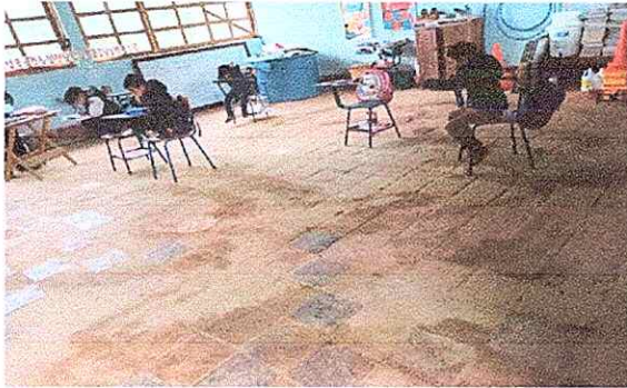
Módulo 1: Sustitución de piso de ladrillo a piso de concreto
