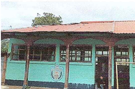
Módulo 1: Sustitución de lámina por lámina troquelada y sustitución de estructura portante de madera por metal.
