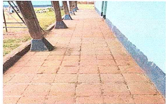
Módulo 1: Sustitución de piso de ladrillo a piso de concreto
