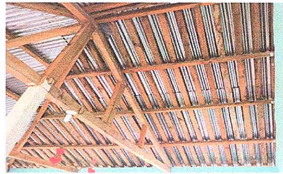
Módulo 1: Sustitución de Lámina y Sustitución de estructura de soporte de madera por metal .
