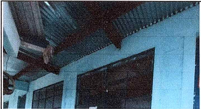
Foto 9: Mantenimiento a estructura
