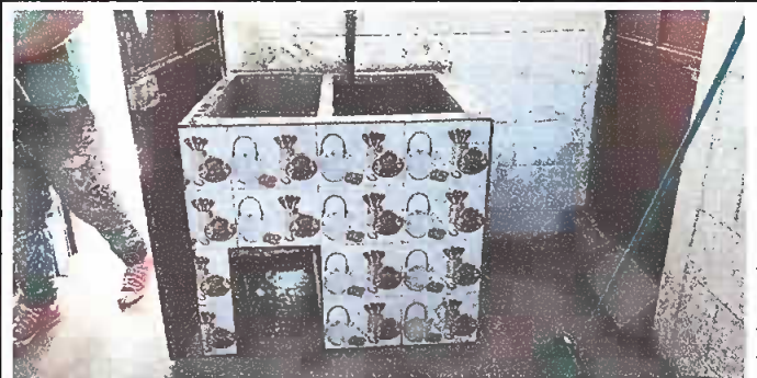
Foto 6: Sustitución de pila de concreto
