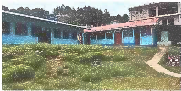
Foto 5: Sustitución de calales pvc
