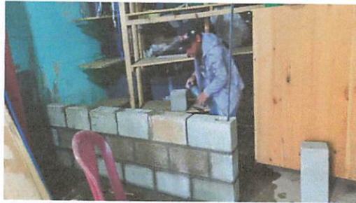
Foto1: Colocación de block de pared
