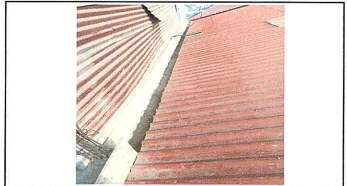
Foto 2: Sustitución de laminas
