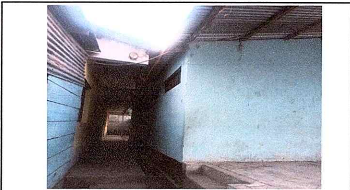
Foto 3: Sustitución de canales PVC
