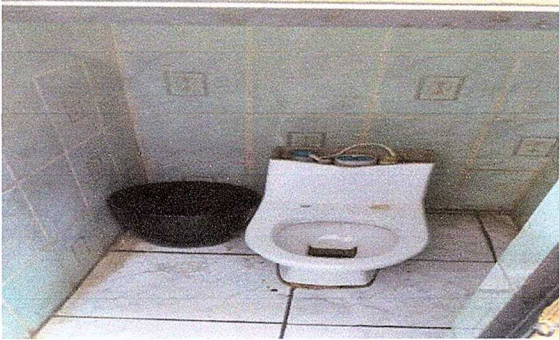
Modulo 3: Sustitucion inodoro
