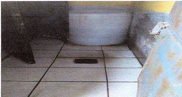
Modlo 5: Sustitucion de Deposito de agua
