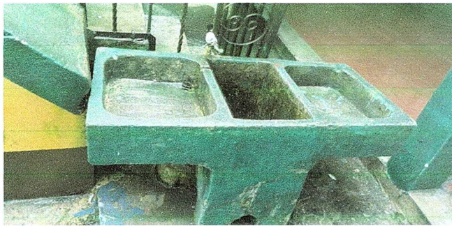
Modulo 9: Sustitucion de Pila de Cemento de Dos lavadearos
