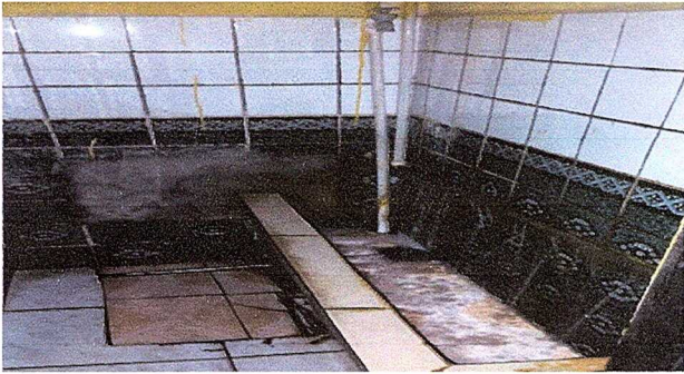
Modulo 1: Sustitucion piso torta de concreto por piso antideslizante
