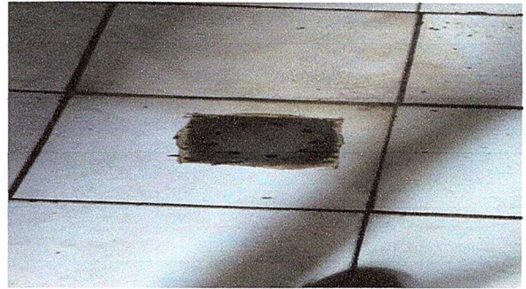
Modulo 2: Sustitucion de tuberia PVC Linea principal aguas negras
