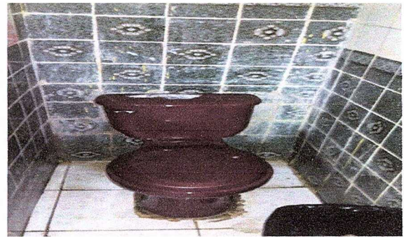
Modulo 4: Sustitucion de azulejos
