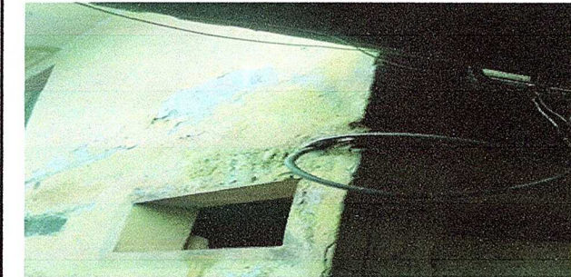
Modulo 7: Reparación de cableado Electrico
