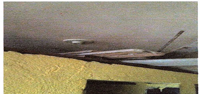
Modulo 6: Sustitucion de Plafonera
