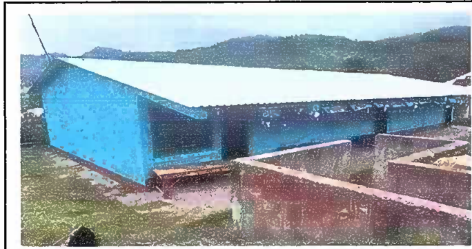
MODULO I Foto1: Sustitución de lámina, popr lamina troquelada.
