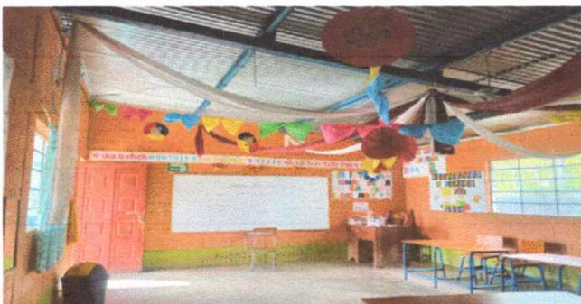
Foto 5: MODULO DOS. Mantenimiento de estructura metalica.
