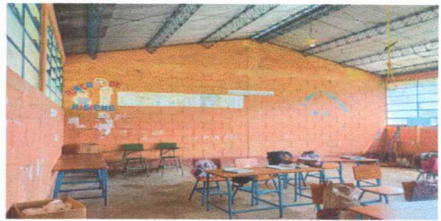
Foto 8: MODULO UNO. Pintura Interior
