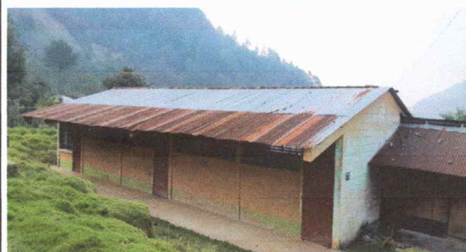
Foto 3: MODULO UNO. Mantenimiento de cuatro puestas lijado, cepillado y reparacion de visagras.
