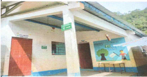
Foto 9: MODULO DOS. Pintura exterior
