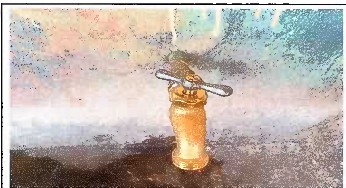
Foto 9: Sustitución de llaves de chorro
