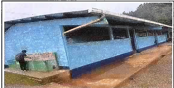
Foto 6: Pintura en paredes interiores y exteriores
