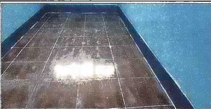
Foto 5: Sustitución de piso cerámico
