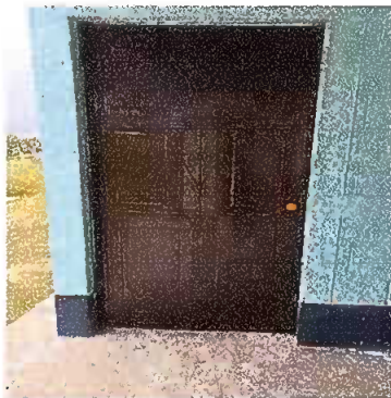
Foto 3: Sustitución de puertas
