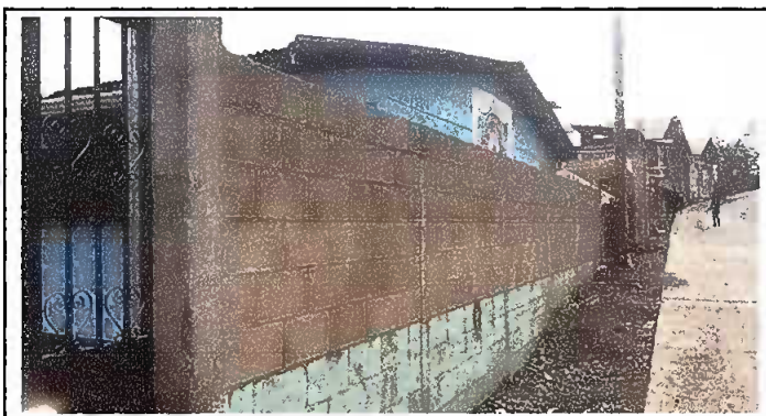
Foto 11: Reparación de muro perimetral.
