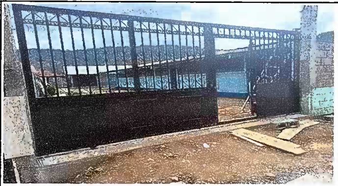
Foto 13: Sustitución de portón.
