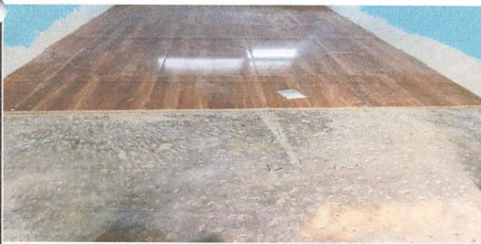
Foto 5: Sustitución de piso cerámico
