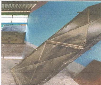
Foto 3: Sustitución de puertas
