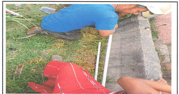
Foto 10: Sustitución de tubería
