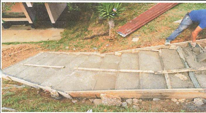
Foto 17: Reparación de gradas.
