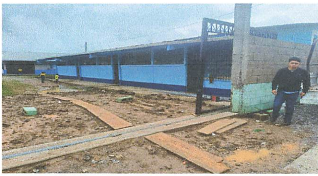
Foto 13: Sustitución de portón.
