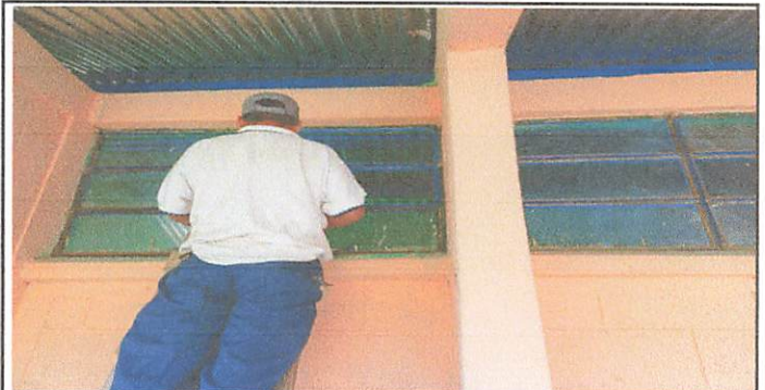
Foto 4: Sustitución de vidrios
