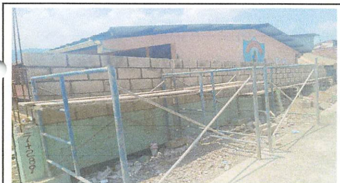
Foto 11: Reparación de muro perimetral.
