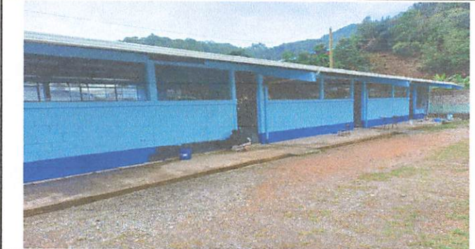
Foto 6: Pintura en paredes interiores y exteriores
