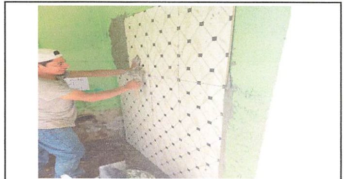
Foto 8: Sustitución de azulejo
