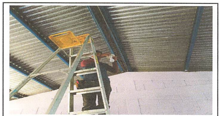
Foto 12: Reparación del sistema eléctrico
