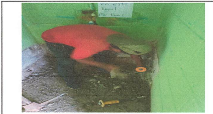
Foto 7: Sustitución de mingitorios
