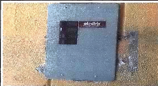
Foto 2: Sustitución de tablero de flipones 104 TL412
