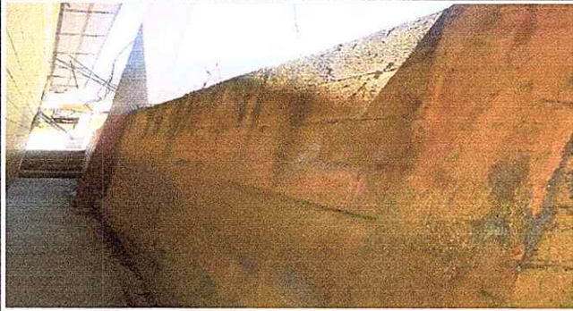
Foto 1 Repello en muro
