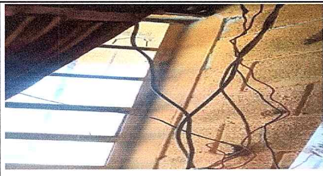
Foto 5: Sustitución de cableado Electrico
