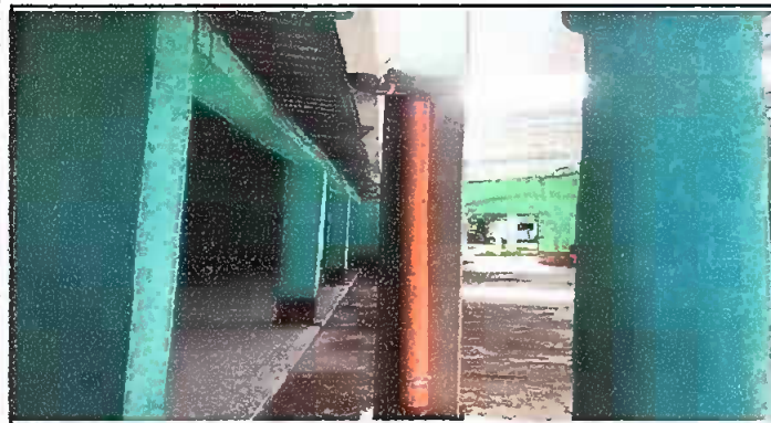
Foto 3: Sustitución de bajada de agua pluvial tubo pvc 3".
