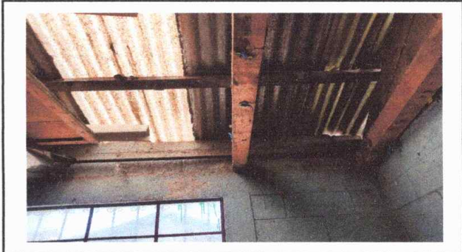
Foto 4: Sustitución de estructura portante de madera por metal
