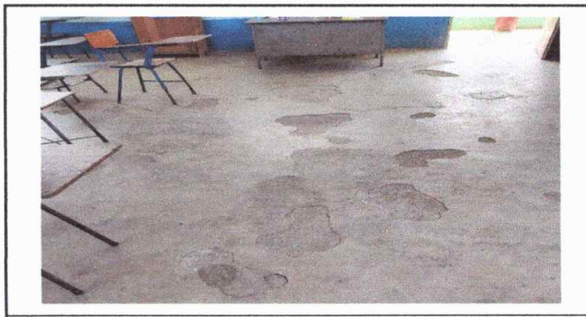
Foto 6: Sustitución de piso
