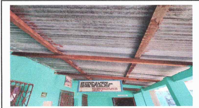
Foto 3: Sustitución de estructura portante de madera por metal
