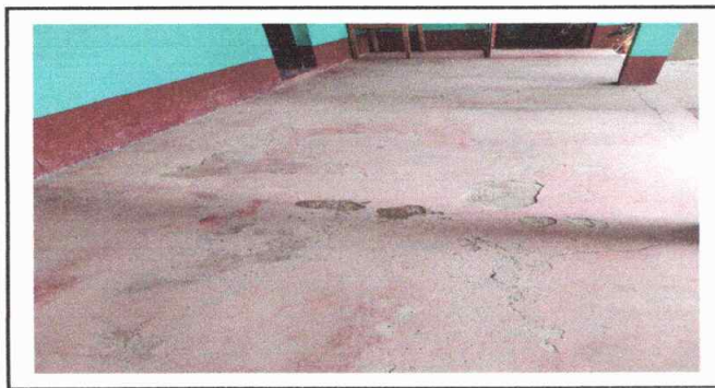
Foto 5: Sustitución de piso
