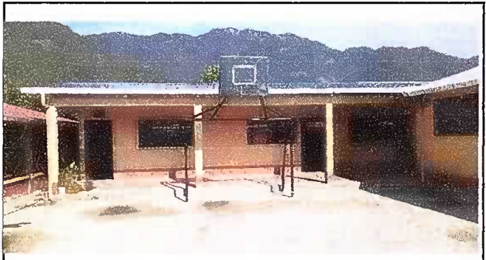
Foto 4: Mantenimiento a estructura de metal de ventana
