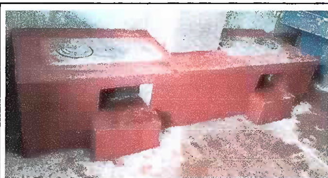
Foto 4: Sustitución de estufa rural (completa) incluye chimenea y plancha de metal
