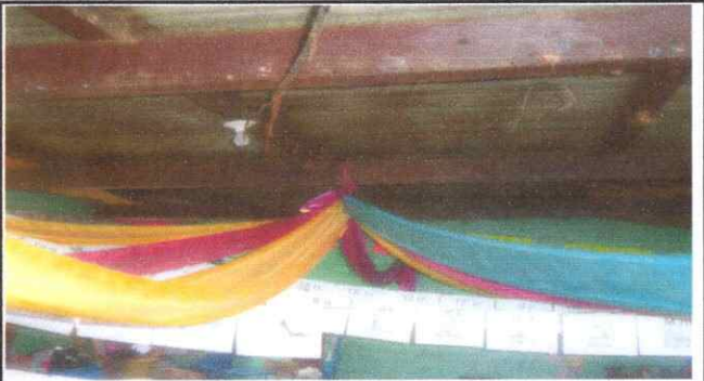
Foto 2: Sustitución de estructura de soporte de madera, por metal M2
