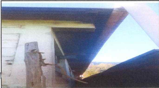
Foto1: Sustrución de canal de Pvc
