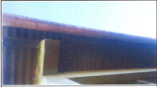
Foto 2: Sustrución de soporte o pescante de metal para canal.
