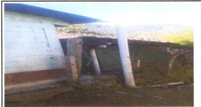
Foto 3: Sustrución de bajada de agua pluvial, tubo pvc 3
