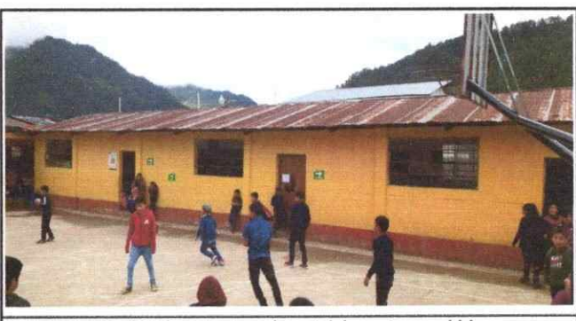
Foto 6: Sustitución de estructura de metal de ventana y vidrios
