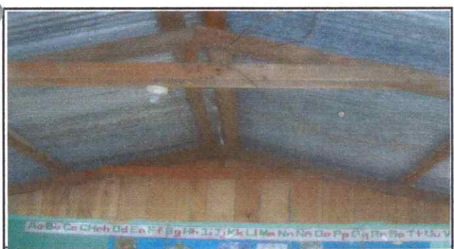
Foto 5: Sustitución de estructura de soporte de madera, por metal M2
