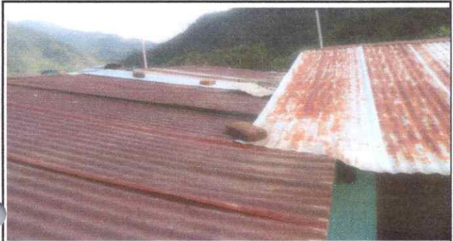
Foto1: Sustitución de lamina por lámina troquelada aluzinc calibre 26 M2
