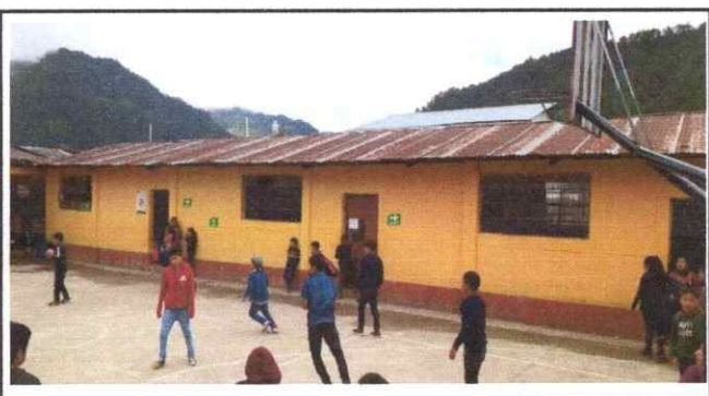
Foto 4: Sustitución de lamina por lámina troquelada aluzinc calibre 26 M2
