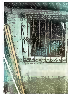
Foto. 6 Sustitución de balcon
