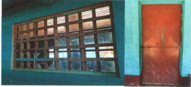
**Modulo 2 Foto 2: Sustitucion de vidrios, sustitución de balcones y sustitucion de chapas**
