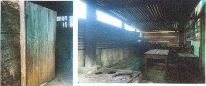
**Modulo 4 Foto 4: Sustitución de puerta de madera a metal, sustitución de lamina por lamina troquelada, sustitucion de estructura de soporte, instalacion de lamina, reparacion de muro de bloc, sustitucion de plancas para pollo.**
