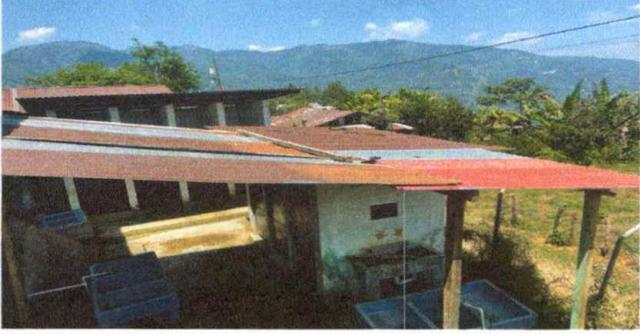
**Modulo 8 Foto 6: Sustitución de lamina por lamina troquelada, sustitución de estructura de soporte de metal, desinstalacion de lamina existente.**
