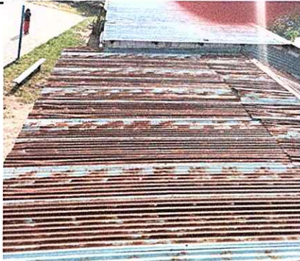
Foto 3: Sustitución de lamina por lamina troquelada
