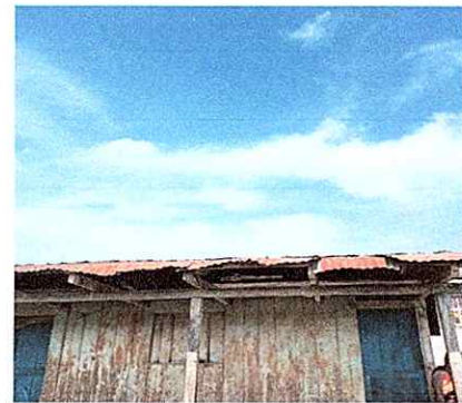
Foto 4: Sustitución de lamina por lamina
