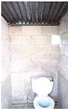
Foto 5: Sustitución de accesorios de inodoro
