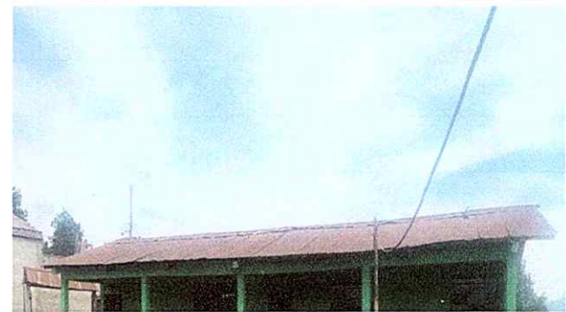
Foto 6: Sustitución de laminas
