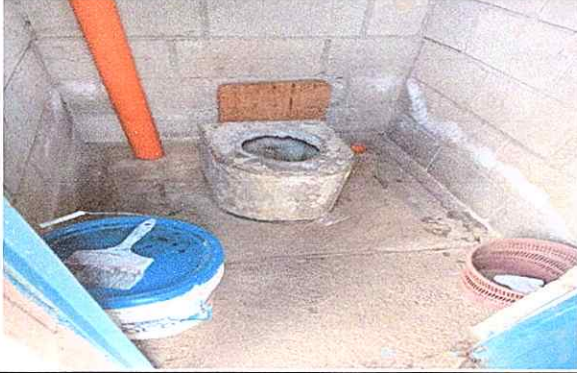
Foto 1: Sustitución de accesorios de inodoro
