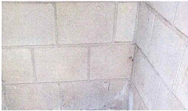
Foto 3: Amplicación de muro perimetral
