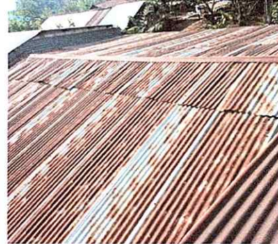
Foto 2: Sustitución de capotes de lamina
