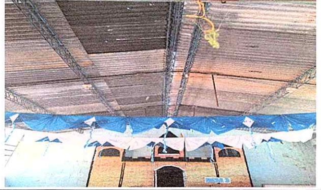
Foto 2: Sustitución de lamina por lamina troquelada y soporte de metal
