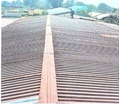
Foto1: Sustitución de capote de lamina
