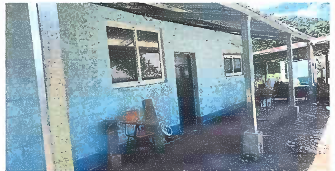
Foto 2: Pintura interior y exterior
