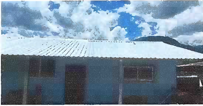
Foto1: Sustitución de lamina a lamina troquelada
