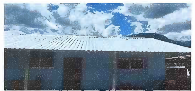
Foto 6: sustitucion de elementos de fijacion (tortinillos)
