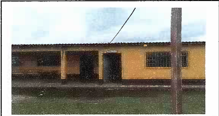
Foto1: Sustrucción de lamina
