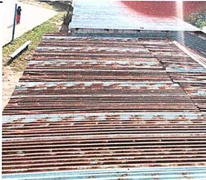
Foto 3: Sustrucción de lamina por lamina troquelada
