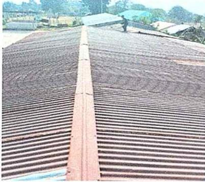
Foto1: Sustrucción de capote de lamina
