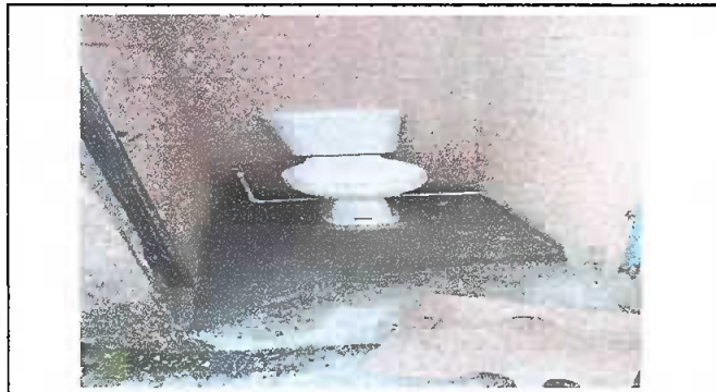
FOTO 1: SUSTITUCION DE INODORO
