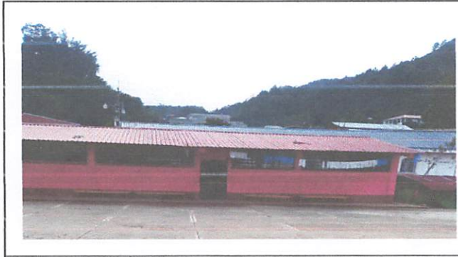
FOTO 2: APLICACIÓN DE PINTURA EN MURO EXTERIORES E INTERIORES
