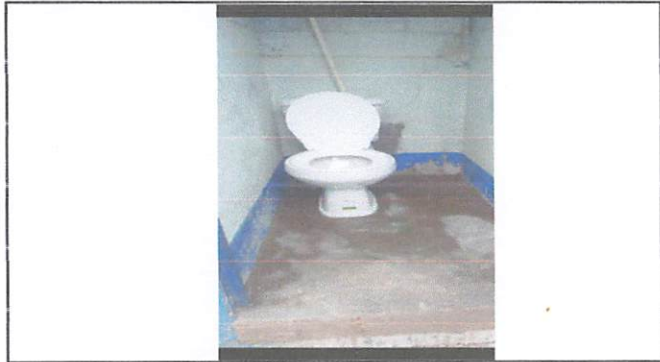
FOTO 1: SUSTITUCION DE INODORO
