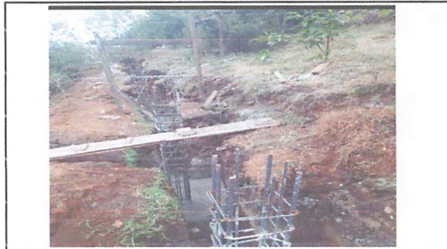
FOTO 4: INSTALACION DE MURO PERIMETRAL
