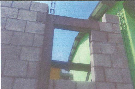
Foto 3: Sustitución de capote
