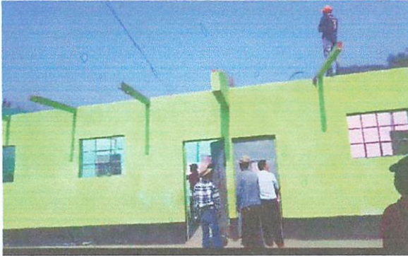
Foto1: Sustitución de lámina por tramila troquelada aluzinc calibre 26
