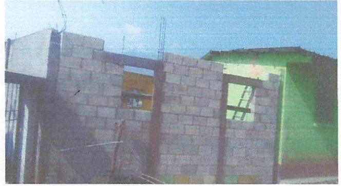
Foto 2: Sustitución de estructura
