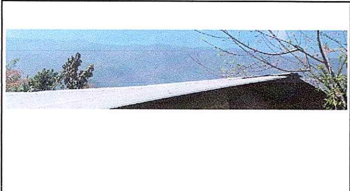
Foto 3: MODULO 2- Sustitucion de capote de lamina para lamina troquelada
