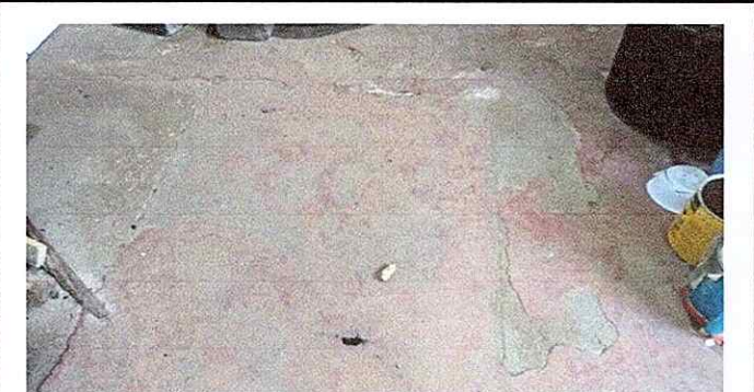
Foto 5: MODULO 1-Sustitucion de piso torta de concreto
