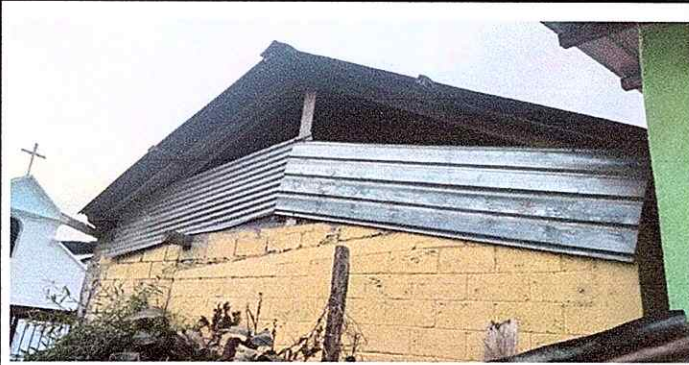
Foto1: MODULO 1-Sustitucion de lamina, por lamina troquelada aluzinc calibre 26
