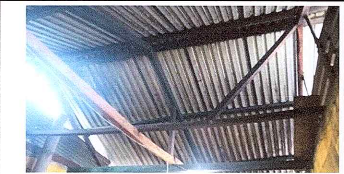
Foto 3: MODULO 1-Sustitucion de estructura de soporte de madera por metal galvanizado
