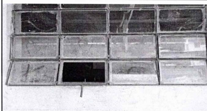
FOTO 3 MODULO 2 SUSTITUCIÓN DE VIDRIOS
