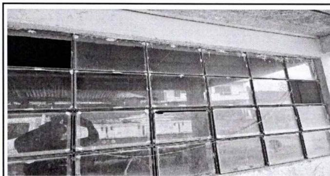
FOTO 5 MODULO 3: SUSTITUCIÓN DE VIDRIOS
