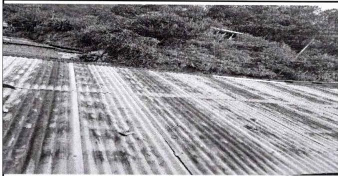
FOTO1 MÓDULO 1: SUSTITUCIÓN DE LAMINA POR LAMINA TROQUELADA ALUZINC CALIBRE 26
