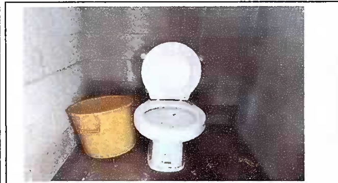
FOTO 3: SUSTITUCION DE INODOROS
