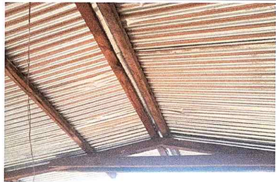
Foto 2: Sustitucion de soporte de madera por metal
