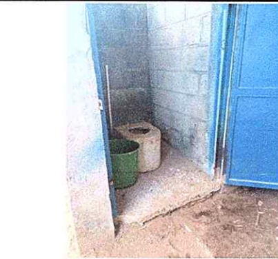
Foto 3: Sustitucion de inodoro
