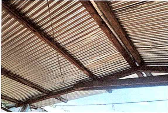
Foto1: Sustitucion de lamina por lamina troquelada
