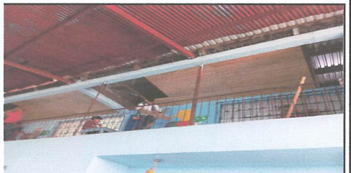
Foto 6: CAMBIO DE MACHIMBRE DE CORREDOR
