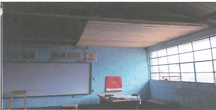
Foto 5: CAMBIO DE MACHIMBRE DE LAS AULAS
