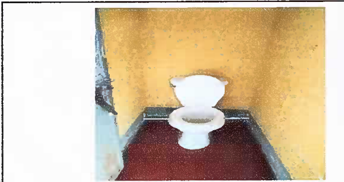
Foto 1: Asi quedaron los sanitarios cuando fueron cambiadas las tasas, a la hora que se termino de ejecutar dicho proyecto.
