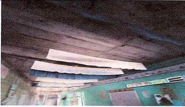
Foto 7: repello del techo de un aula
