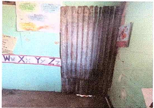
Foto 8: colocacion de puerta
