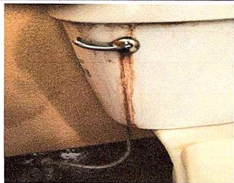
Foto 12: cambio de accesorios de servicios sanitario
