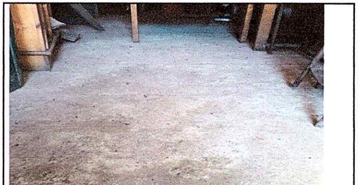
Foto 6: colocacion de piso ceramico
