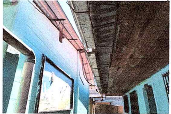
Foto 10: cambio de canales y bajada de agua
