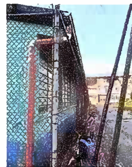
FOTO 6 SUSTITUCION DE BAJADA DE AGUA PLUVIAL
