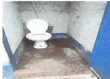
FOTO 4. SUSTITUCION DE INODORO
