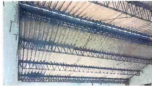
FOTO 2: SUSTITUCION DE ESTRUCTURA DE SOPORTE DE METAL
