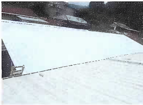
FOTO 3: SUSTITUCION DE LAMINA TROQUELADA
