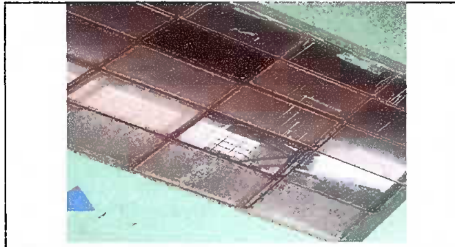
FOTO 1: SUSTITUCION DE VIDRIOS
