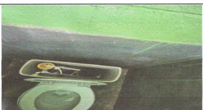
FOTO 5: Módulo 4, Sustitución de inodoro.
