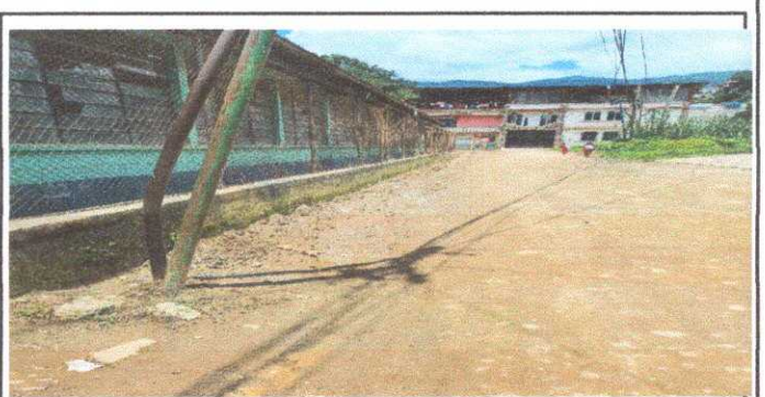
FOTO 6: Módulo 4, Sustitución de tubería PVC línea principal aguas negras.
