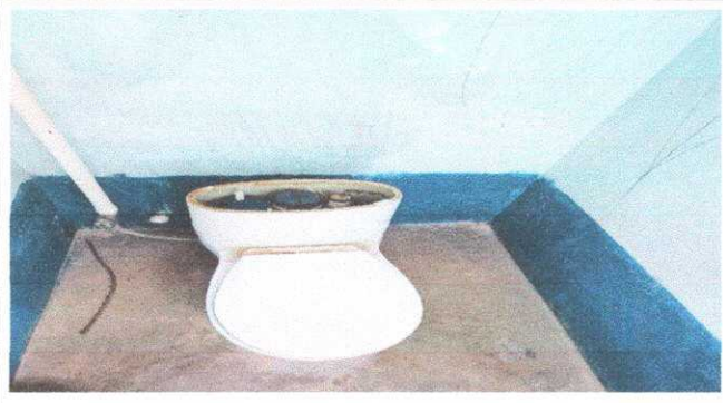
FOTO 1: Módulo 4, sustitución de inodoros
