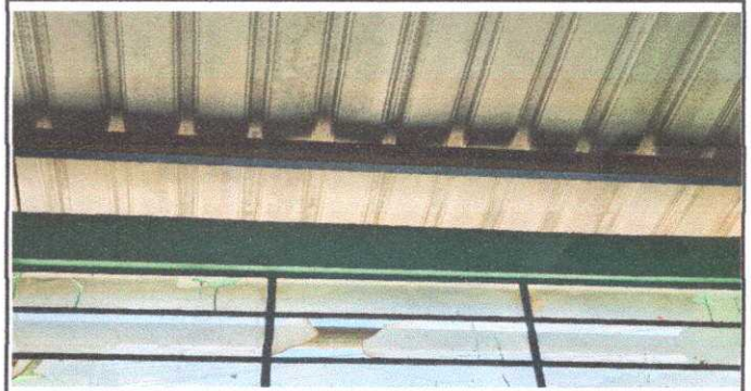
FOTO 8: Módulo 3, Sustitución de vidrios.
