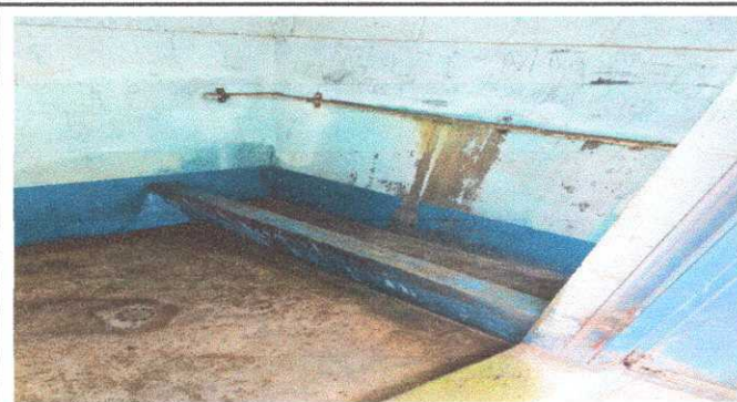
FOTO 3: MÓDULO 4, Sustitución de mingitorio.
