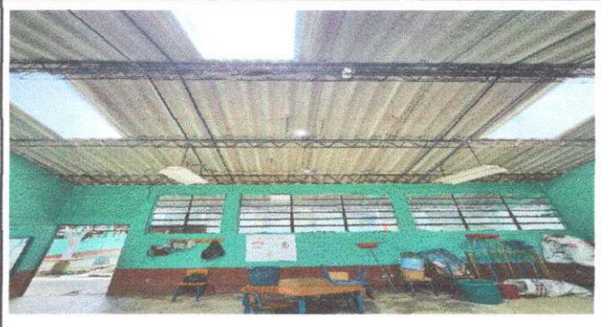
FOTO 2: Módulo 1, sustitución de lamina por lamina troquelada aluzinc calibre 26.
