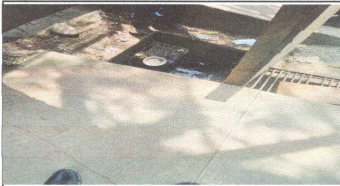
FOTO 9: Módulo 4, Sustitución de caja de registro.
