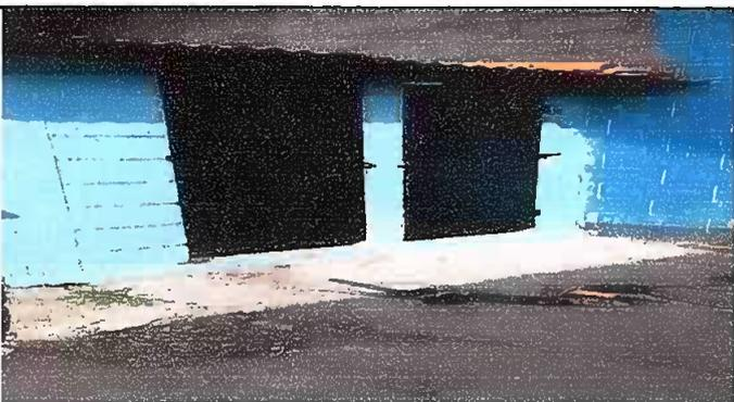
Foto 3: Cambio de puerta de madera por metal.
