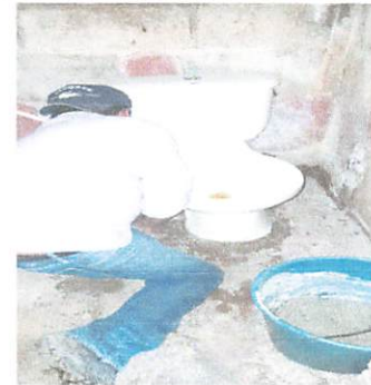
Foto 6: Sustituir 6 tazas para baños de niños
