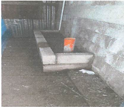
Foto 5: Construcción de migitorio
