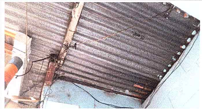
Foto 2: Sustitución del sistema electrico.
