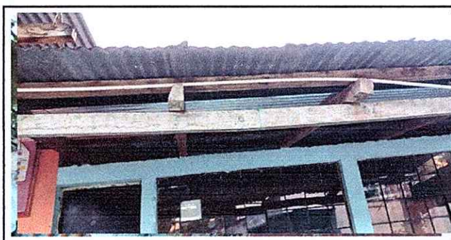
Foto 5: Vigas provisiones en 2 aulas y la cocina.
