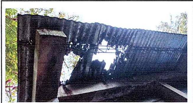
Foto1: Lámina perforada como se ve en la imagen.
