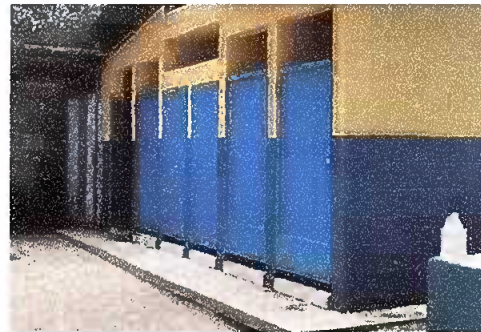
FOTO 6: MODULO 3, mantenimiento y susticion de puertas
