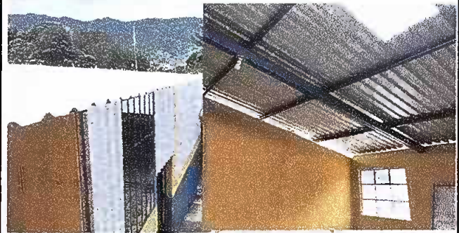
FOTO 4: Módulo 2, sustitucion de lámina y Sustitucion de soporte de madera por metal.
