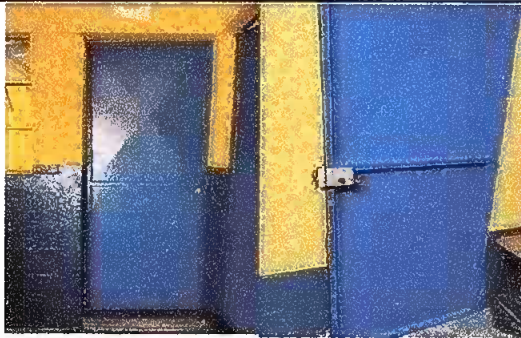
FOTO 3: Módulo 2, sustitucion de chapas y mantenimiento de puertas
