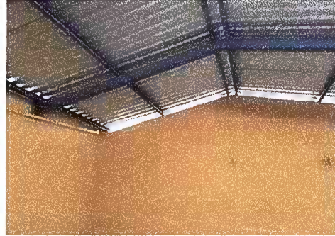
FOTO 2: Módulo 1, sustitucion de estructura de soporte de madera por metal
