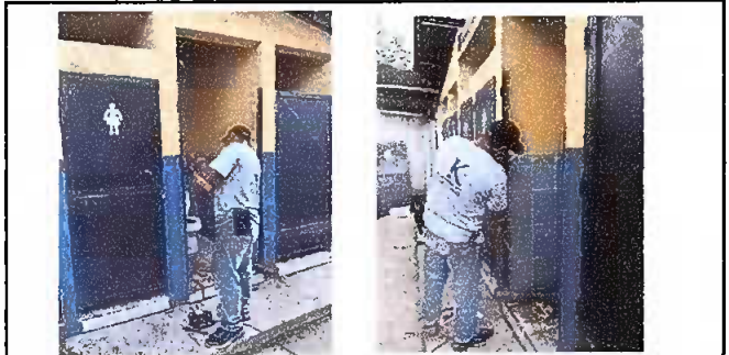
FOTO 6: MODULO 3, mantenimiento y susticion de puertas
